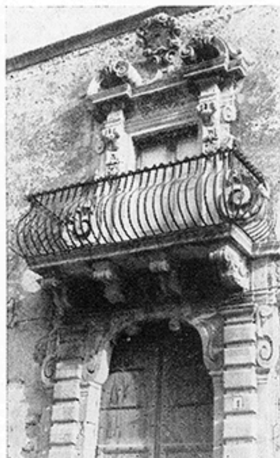
Palazzo Truncali-Panitteri-Amodei: balcone centrale, particolare.
