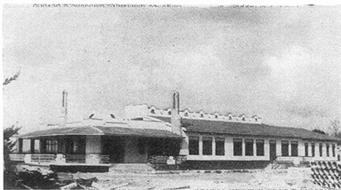
Sambuca di Sicilia - Questo edificio che qui nella foto appare in costruzione, è stato già ultimato. Si tratta di un complesso scolastico modernissimo che entrerà in funzione coll'apertura del nuovo anno scolastico.
