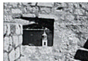
Carlo Laro "Particolari architettonici" dal 2 al 15 gennaio
